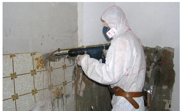
1 Platten mit asbesthaltigem Kleber müssen mit einem Kangohammer mit Wassersprührichtung nass entfernt werden.
