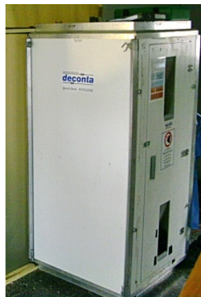
2 Eingang zur Sanierungszone (Schleuse, abgedichtet)
