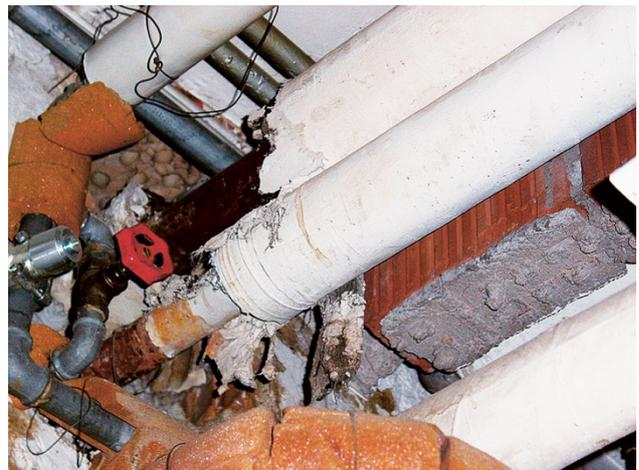
1 Rohrisolation mit asbesthaltigem Mörtel
