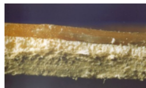
2 Dreischichtiger Cushion-Vinyl. Die unterste Schicht enthält über 40 Prozent Chrysotilasbest.
