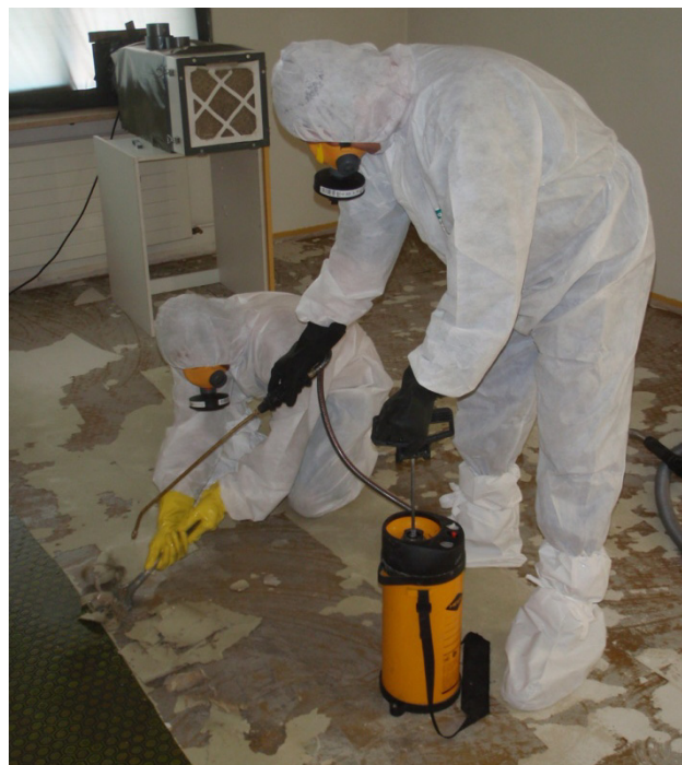
6 So wird der Belag entfernt.
