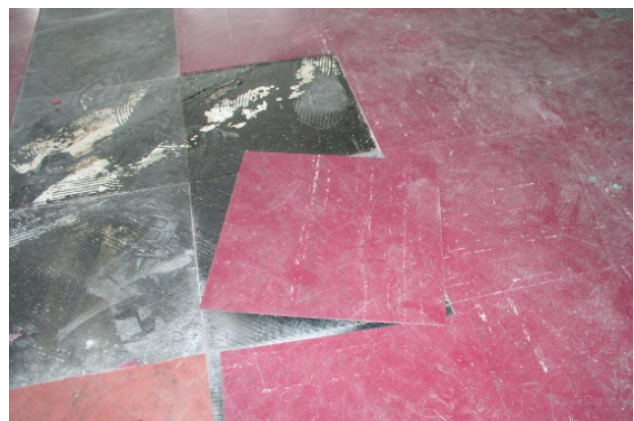
1 Ein einschichtiger sogenannter Floor-Flex-Belag.
