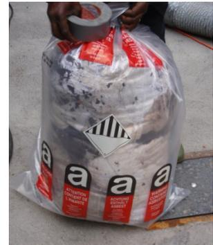
4 Kunststoffsack mit der Kennzeichnung Asbest
