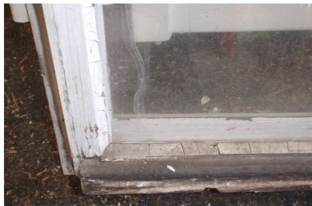
1 Asbesthaltiger Leinölkitt an einem Holzfenster
