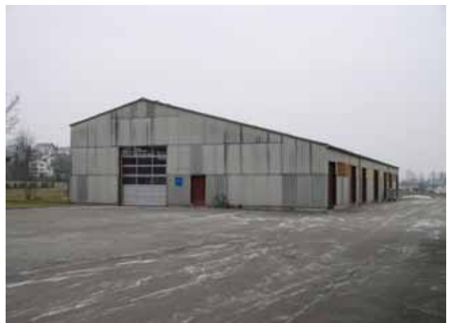
1 Mit Wellplatten aus Faserzement verkleidete Industriehalle
