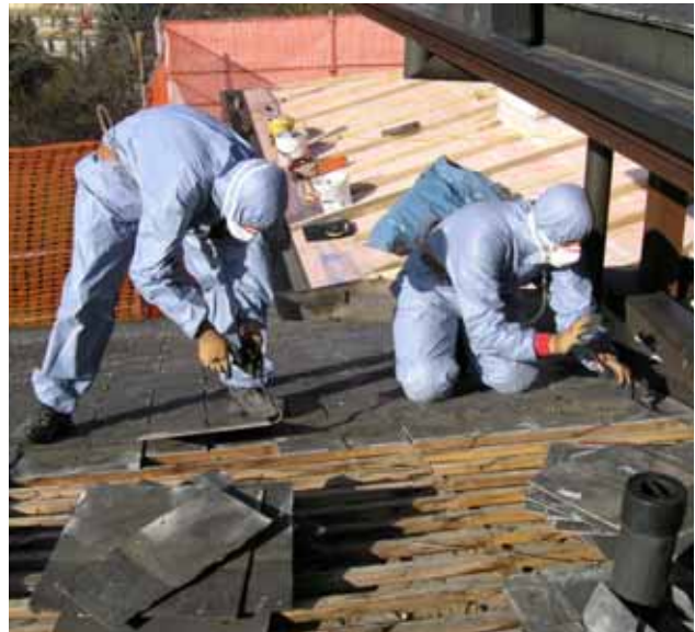
3 Um Gesundheitsgefährdungen zu vermeiden, ist die Demontage zerstörungsfrei und mit der richtigen Schutzausrüstung auszuführen.
